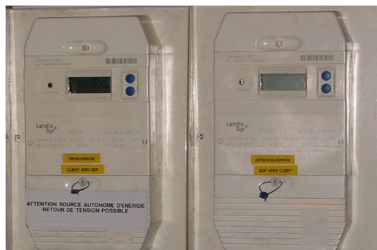
Exemple d'un compteur de production (à gauche) et d'un compteur de non-consommation (à droite) pour les installations inférieures ou égales à 36 kVA
